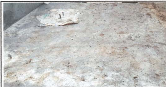
Foto 6: MODULO 2 AULAS Sustitución de fosa séptica
