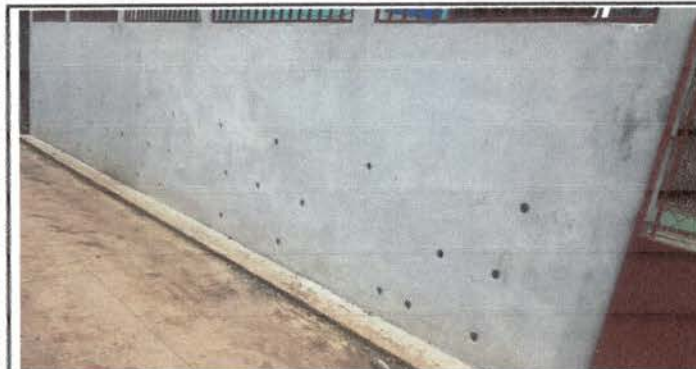
Foto 1: MODULO 1 MURO Reparación de muro perimetral de block con soleras intermedias y columnas
