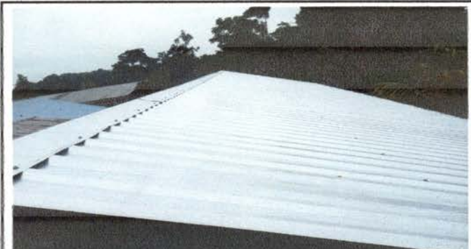
Foto 4: MODULO 2 AULAS Sustitución de lámina, por lámina troquelada aluzinc calibre 26
